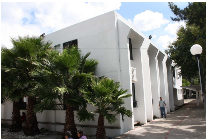
Edificio 103C, Posgrado en Dispositivos Semiconductores.
